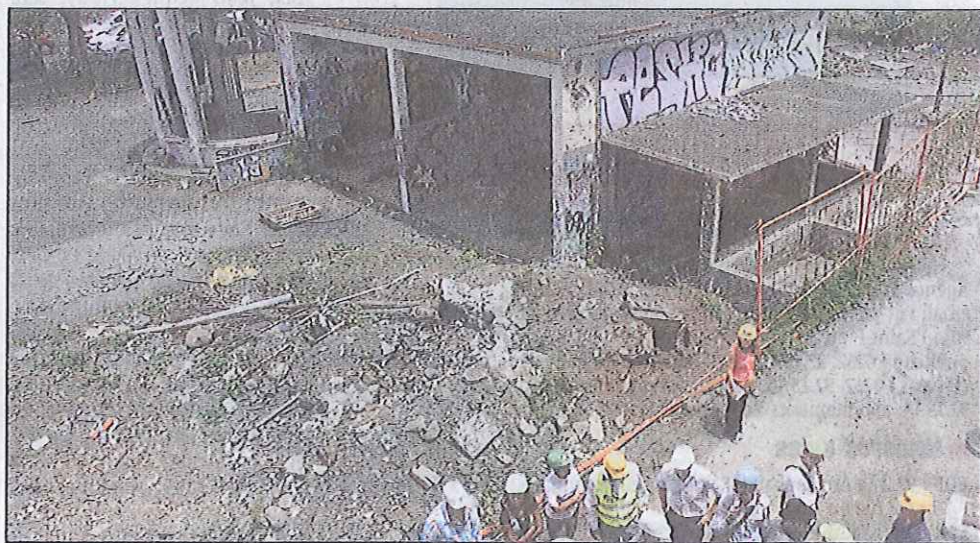
Future porte d'entrée de la Cité des Arts, l'ancienne station-service sera démolie à partir de lundi. (Photos Philippe Chan Cheung)
